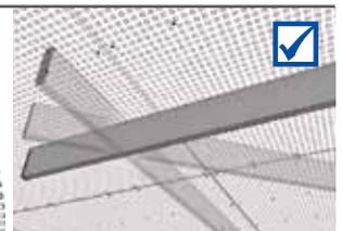
Изнаначное изоляционное покрытие укладывать непосредственно на потолочные плиты
