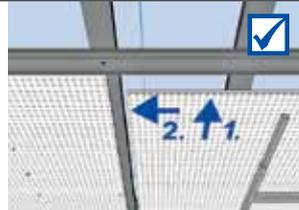
Привинчивать болты попарно вдоль всей плиты в зоне ее стыка ("зигзагом"), начинать с левой или правой стороны предварительно установленного фиксирующего винта, чтобы получить ровный стык
