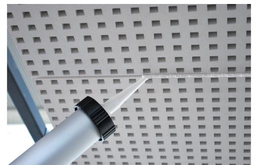
Das Material selbst ist verarbeitungsfertig eingestellt und verfügt über eine cremige Konsistenz. Um die Gefahr von nachträglicher Rissbildung zu minimieren, ist die Spachtelmasse faserverstärkt und verfügt über eine sehr hohe Dichte.
