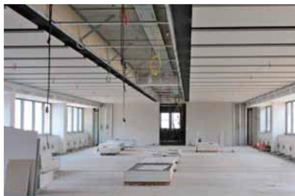
Hier sind die Deckensegel der Büros bereits montiert. Die Akustikdecke im Gang wartet noch auf die Ausführung
