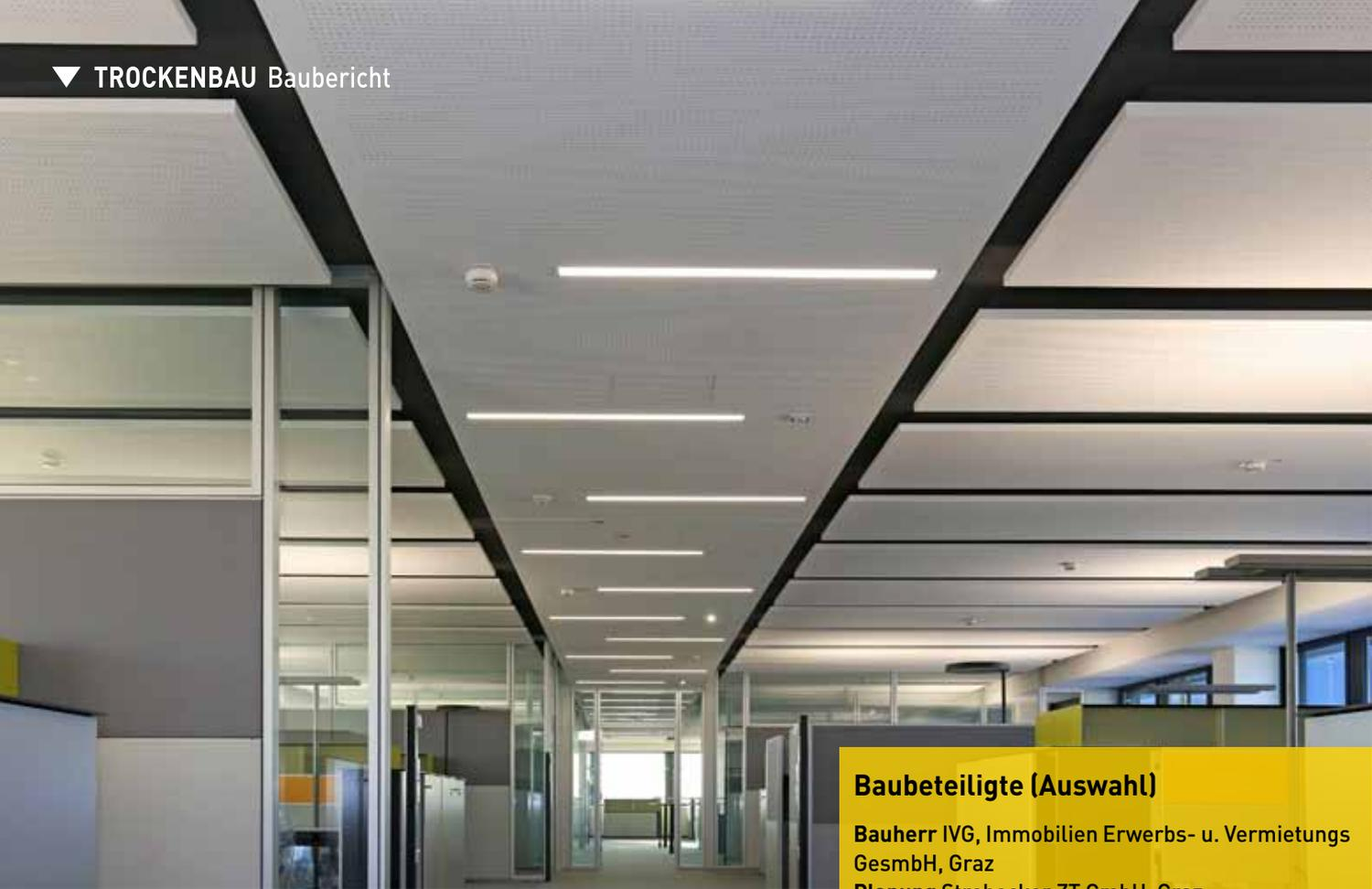
Die mit Akustikdesigndecken und Deckensegeln anspruchsvoll gestalteten Büroräume nach Abschluss der Maler- und Trockenbauarbeiten
