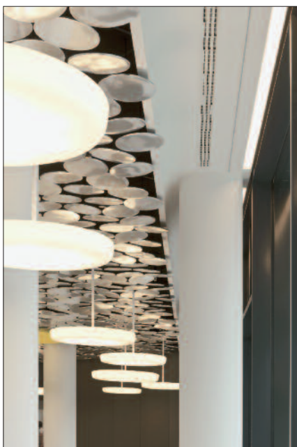
Die Deckenkoffer sind ab Werk hergestellte Formteile mit ungelochten Rändern und einer V-Fräsung.
