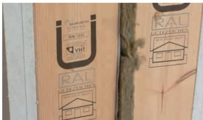
Abb. 04 Kennzeichnung von werkseitig vorgefertigten Wandelementen
