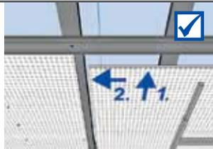
Dans la zone de jointure des plaques, serrer les vis par paires en alternant d'une plaque à l'autre (« principe du zigzag »). Commencer à gauche ou à droite, à proximité de la vis de fixation déjà posée. Cette méthode donne des zones de jointure planes
