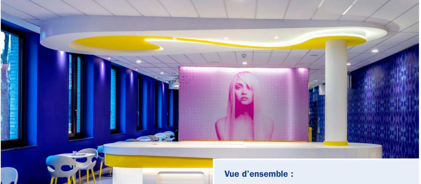
Les éléments en placoplâtre permettent une grande variété de conceptions possibles. Grâce à la conception en 2D ou en 3D, des structures complexes et enchevêtrées peuvent également être créées à partir de panneaux. Dans le cas de cette pièce moulée placée au-dessus d'un comptoir, la valeur ajoutée pour l'entrepreneur spécialisé résidait dans la conception largement préfabriquée et la forme définie en usine avec sa voûte intégrée pour l'éclairage indirect de la structure.
