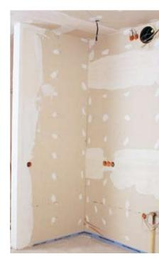
**Arbeitsgang gespart.** Die neue 25 mm dicke Platte reduziert den Arbeitsaufwand überall dort, wo normalerweise eine zweilagige Beplankung mit 12,5 mm dicken Gipsplatten erfolgen muss.
