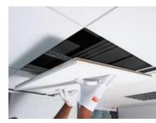
**Versteckt.** Durch die spezielle Kantenfräsung der Akustikdecke wird die Schienenkonstruktion bis auf eine 7 mm breite Schattenfuge komplett verdeckt.
