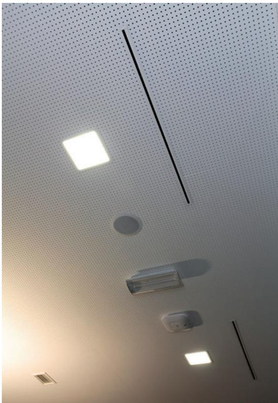
**Bild 3.** Die schalltechnisch hochwirksame gelochte Deckenplatte ergibt ein homogenes Deckenbild (Fotos: Vogl Deckensysteme)
