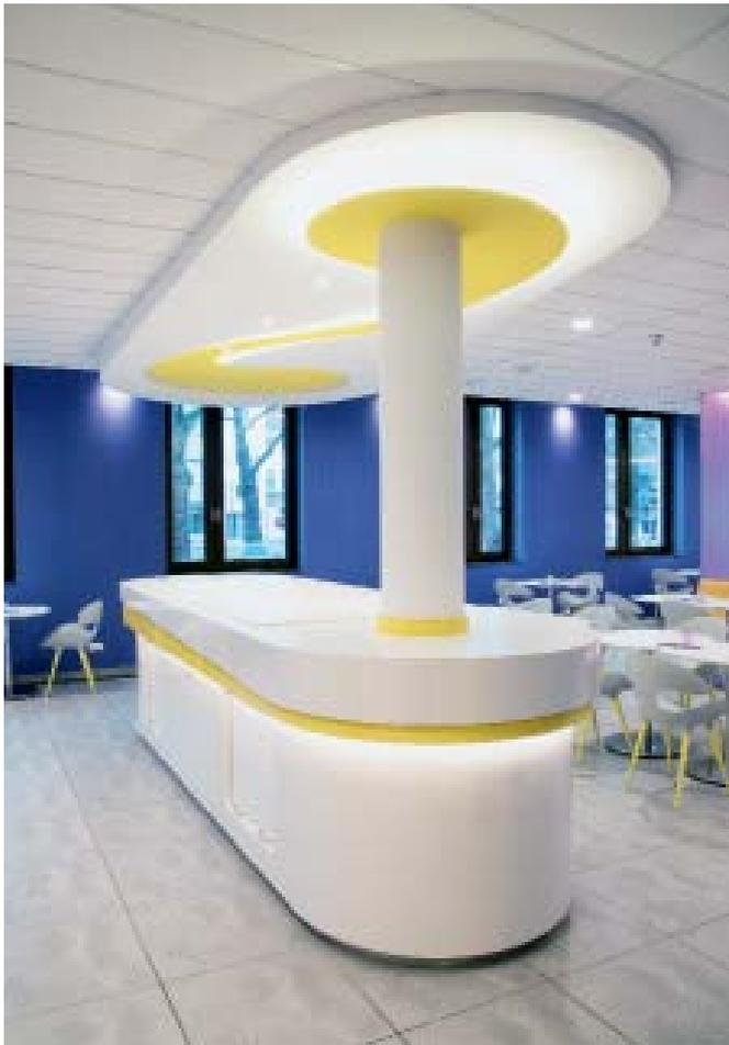
**Erhöhter Montageaufwand.** Die Lichtvoute wechselt über ihre Länge von innenliegend nach außenliegend.
