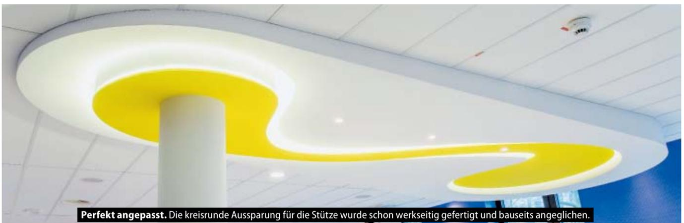
**Perfekt angepasst.** Die kreisrunde Aussparung für die Stütze wurde schon werkseitig gefertigt und bauseits angeglichen.
