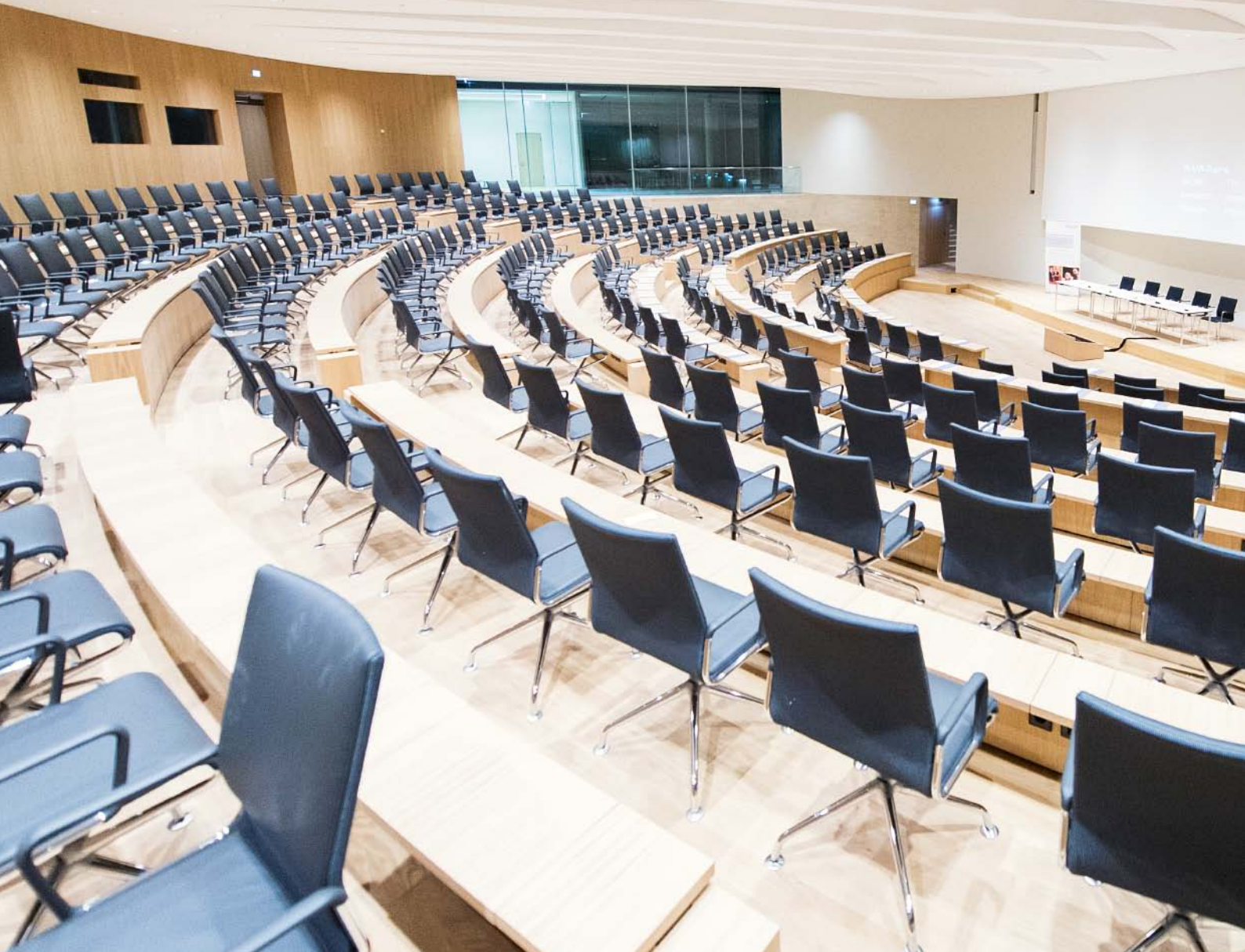
Hörsaalgebäude. Besonders die „Formteilwellen“ im Hörsaal sind das i-Tüpfelchen einer anspruchsvollen Innenarchitektur. Um diese Form zu erreichen, waren die Höhenpunkte an den verkleideten Stahlunterzügen durch den Trockenbaufachmonteur eingemessen worden, erklärt Bauleiter Holger Bock.
