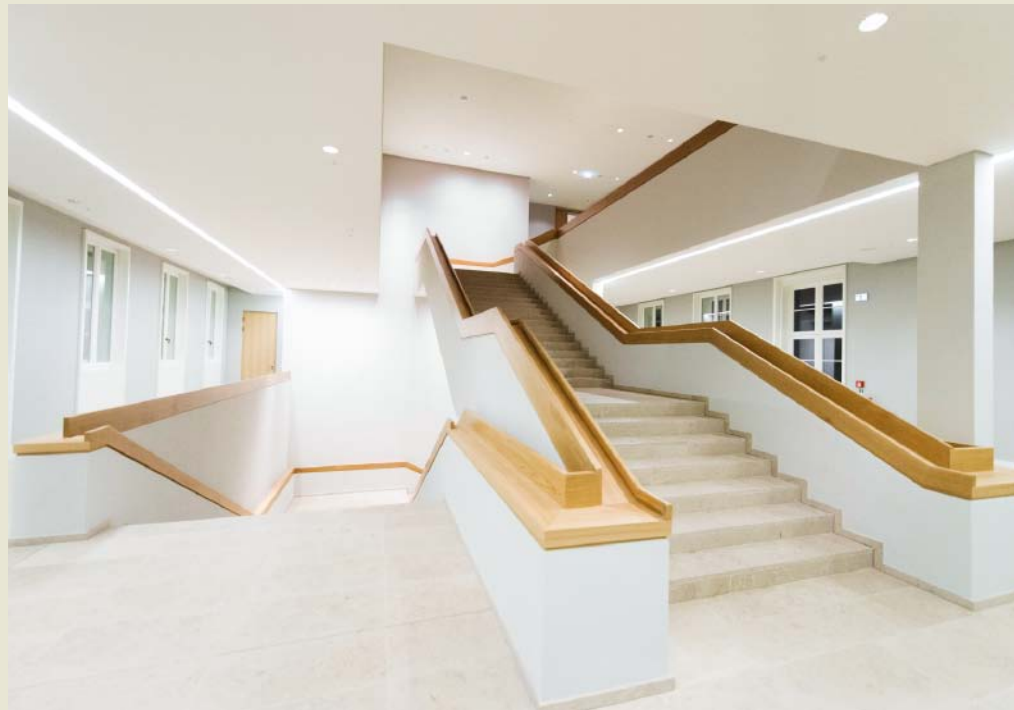
Lichtleisten. Im Tagungsbereich mit den öffentlichen Flächen wie Flur und Foyer wurden immerhin noch ca. 350 m 2 GK-Deckensysteme eingesetzt.
