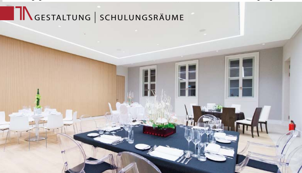
Flächig integriertes Licht. Im Bereich der Tagungsräume war eine flächige Decke gewünscht. Lichtschächte auf vorgefertigten Elementen machten einen effizienten Baufortschritt möglich.
