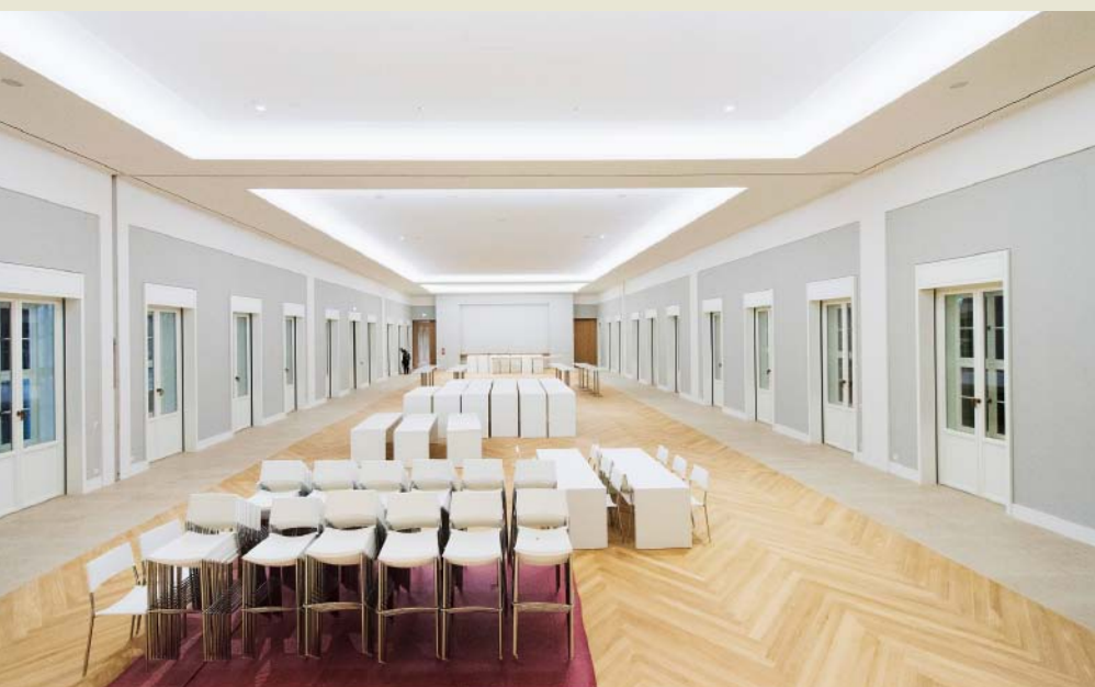
Repräsentationsräume. Im Festsaal, in der Bar und im Seminarraum wurden halbrunde Formteile eingebaut. Beim Installieren dieser Formteile achtete der Trockenbaufachmonteur darauf, dass sich die Anschlüsse der Formteile gut miteinander verbinden ließen.
