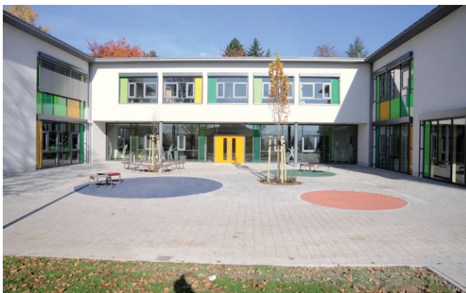
Bild 1. Transluzente Farbgläser in hell- und dunkelgrün sowie orange betonen die Außenfassade
