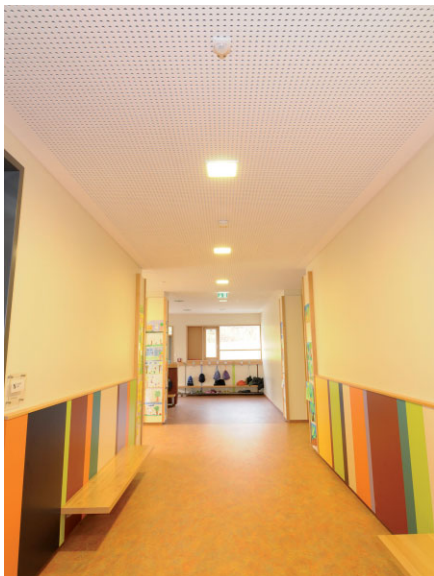
Bild 3. Tobende Schüler im Gang sind kein Problem: Die Akustikdecke nimmt den Schall auf
