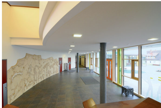
Bild 5. Diese schallschluckende Deckenkonstruktion im Pausenraum des Untergeschosses hat Lautsprecher, Lichtelemente und Sprinklereinbau
