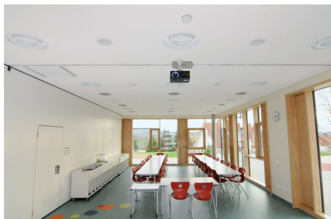
Bild 6. Dieser Raum lässt sich zum Mehrzweckraum verändern; die Deckenkonstruktion enthält die dazu notwendigen Einbauten wie Licht, Lautsprecher etc.
