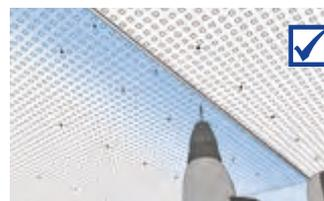
**Important !** Une fois les joints constitués, ne plus exercer d'action mécanique sur la surface du plafond.
