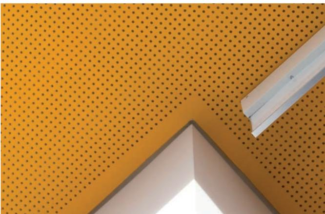
VoglColorplatten bieten die Möglichkeit werks- und bauseitiger Farbgebungen durch Farbkombinationen aus Deckschicht, Lochlaibung und Vliesfarbe.
