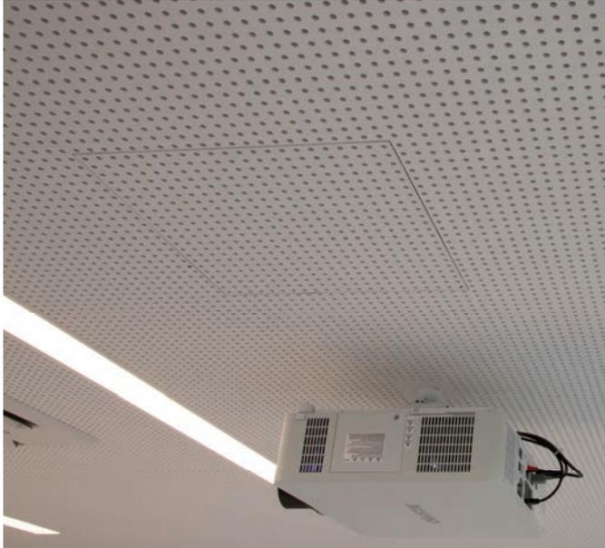
Durch die serienmäßige Fangsicherung (bei Revisionsklappen > 300 mm) wird ein unbeabsichtigtes Herabfallen des Revisionsklappeneinsatzes beim Öffnen verhindert. Für die Arbeiten im Deckenhohlraum kann der Einsatz dann komfortabel ausgehängt und herausgenommen werden.
