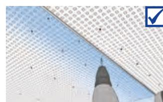
Contrôler les zones de jointure des plaques et les têtes de vis, le cas échéant, corriger les différences de hauteur à l'aide d'un tournevis.
