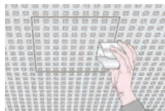
Avec une perceuse pour métaux, prépercer le cadre de la trappe d'inspection Vogl puis le fixer à l'aide des vis SN pour plaques perforées.
