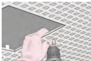
S'applique ici le principe suivant : au moins 2 vis par côté de cadre pour une trappe < 500 x 500 mm et au moins 3 vis par côté de cadre pour une trappe > 500 x 500 mm.
