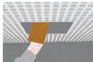
Chanfreiner ensuite légèrement le côté visible de la plaque acoustique design au cutter de manière à faciliter le spatulage ultérieur. Puis poser le cadre de la trappe d'inspection Vogl et le fixer avec un auxiliaire de montage en tenant compte de la configuration des perforations.
