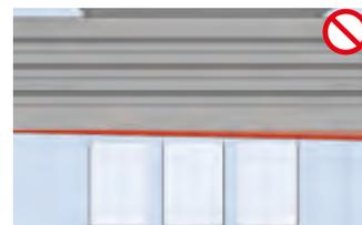
Puis, contrôler les écartements des profilés de plafond CD et réajuster le cas échéant. Les raccords longitudinaux doivent toujours être montés en quinconce (cf. illustration). Mesurer correctement les écartements !
