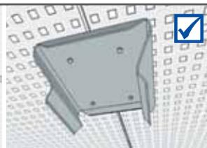
Una volta che i pannelli sono installati, controllare che tutti i giunti siano ben allineati (se necessario sistemarli utilizzando un avvitatore). Effettuare un nuovo controllo visivo della configurazione dei fori ed infine controllare la superficie del soffitto con la stadia.
