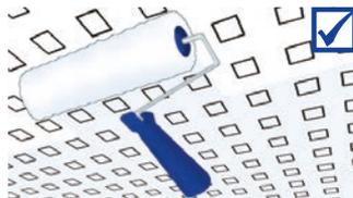
Aplicar el adhesivo especial VogIToptec saturado y uniforme con un rodillo de piel de cordero y colocar de inmediato el velo de soporte del revoque en el lecho de pegamento fresco; presionar con espátula de empapelar. No se permite pulverizar el adhesivo.
