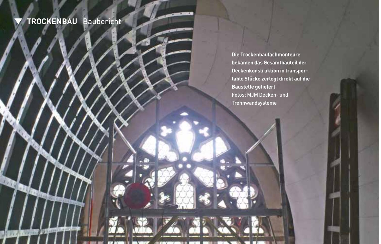
Die Trockenbaufachmonteure bekamen das Gesamtbauteil der Deckenkonstruktion in transportable Stücke zerlegt direkt auf die Baustelle geliefert
