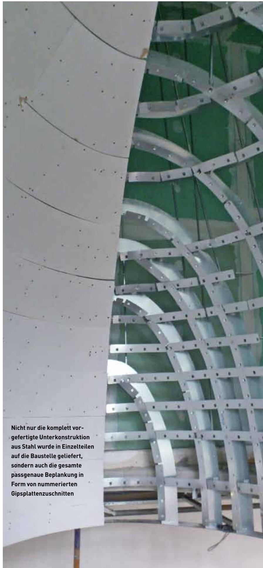
Nicht nur die komplett vorgefertigte Unterkonstruktion aus Stahl wurde in Einzelteilen auf die Baustelle geliefert, sondern auch die gesamte passgenaue Beplankung in Form von nummerierten Gipsplattenzuschnitten
