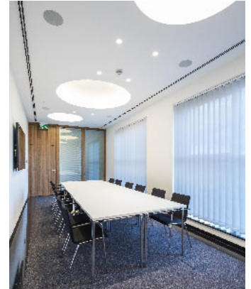
/ Licht-Rotunden aus glasfaserverstärkten Gipsformteilen der Baustoffklasse A1.
