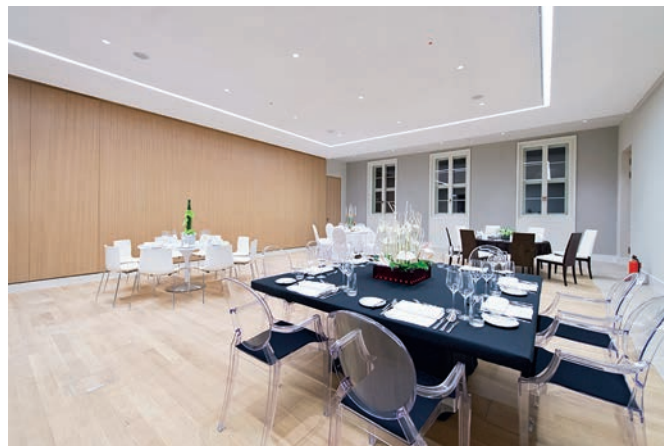
Bild 5. Die gelochte Akustikdecke wirkt optisch wie eine ungelochte Decke (Fotos: Nico Herzog)
