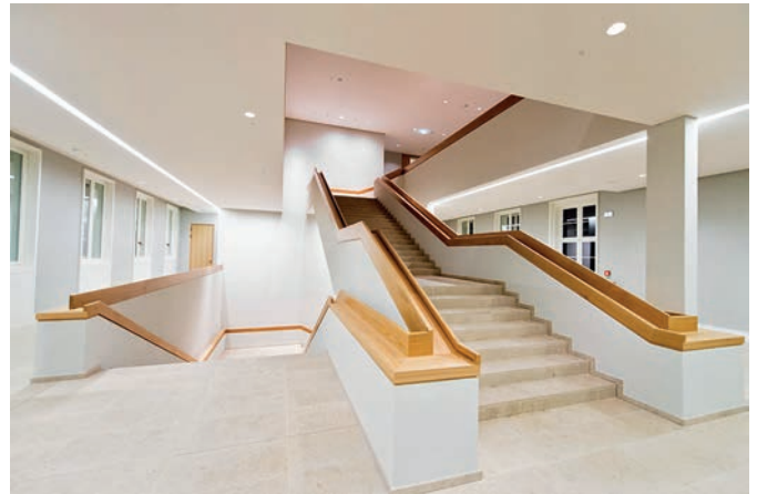
Bild 2. In die Decke sind Lichtband und Beleuchtungselemente installiert
