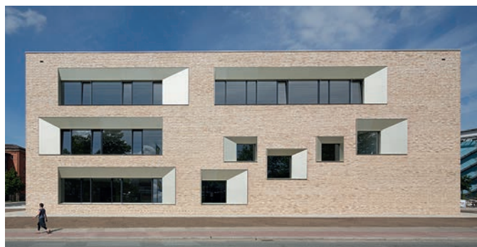
Bild 1. Harmonisch fügt sich die massive Lochfassade aus Ziegelstein der Hochschule Ansbach in die Umgebung ein
