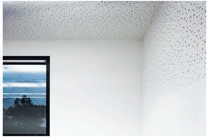
Bild 6. Perfekt ist der weiche Übergang zwischen den Flächen mit und ohne Lochung (Fotos: Marcus Ebener)
