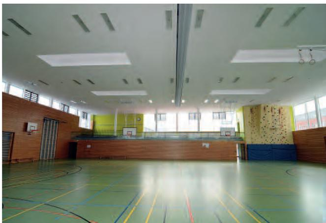
**Bild 1.** Ballwurfsichere und akustisch optimale Sporthallendecke mit Luftreinigungseffekt
