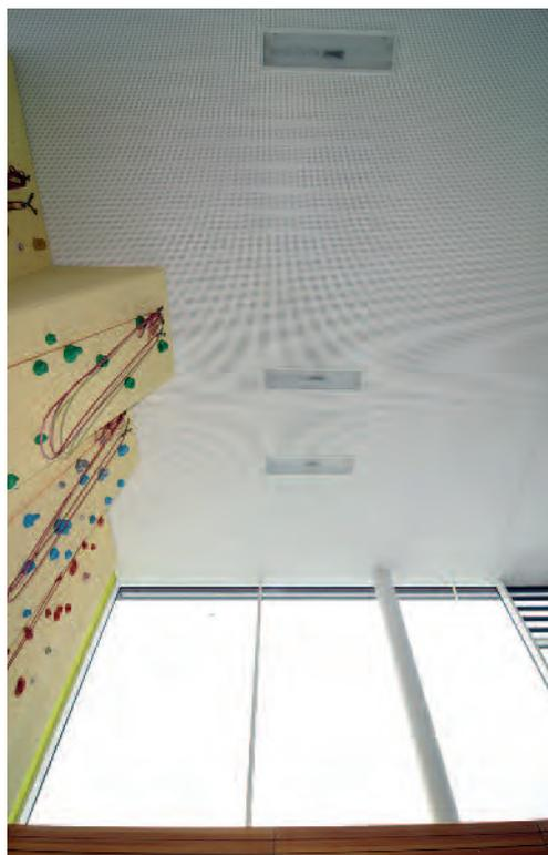
**Bild 2.** Die Deckenplatten sind in unterschiedlichen Lochbildern – rund oder quadratisch – und einem Lochflächenanteil von 8,7 % bis 23,0 % erhältlich
