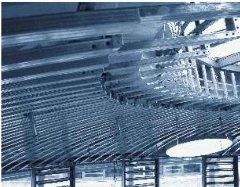
**1** Drucksteif und stabil: Abhängung und Unterkonstruktion sind die Basis einer Akustikdesigndecke, die allen Erschütterungen standhält.
