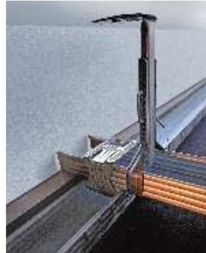
**3** Die äußeren Abhänger dürfen maximal 10 cm Abstand zur Wand haben. Auf einem umlaufenden UD-Profil lässt sich der Grobrost komfortabel auflegen. Das spart Zeit. Den Feinrost darf man jedoch nicht mit dem UD-Profil verschrauben.
