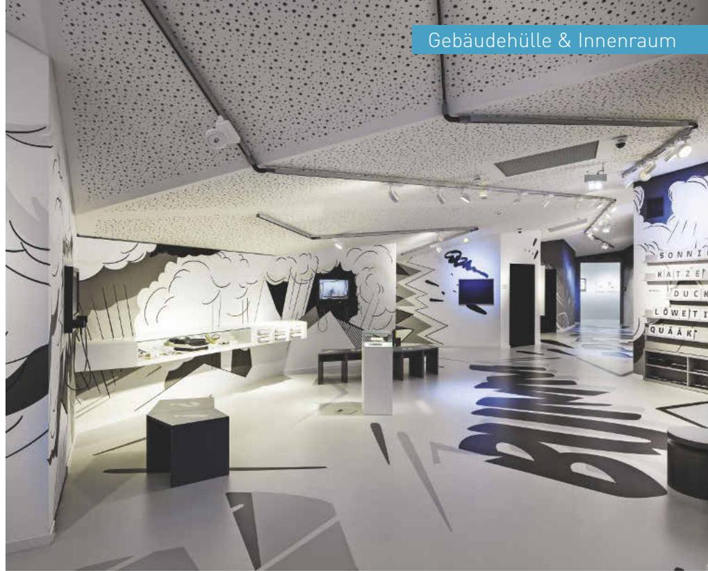
Das Obergeschoss ziert eine gefaltete Vogl Thermotec-Decke, System Spachtelfuge.
